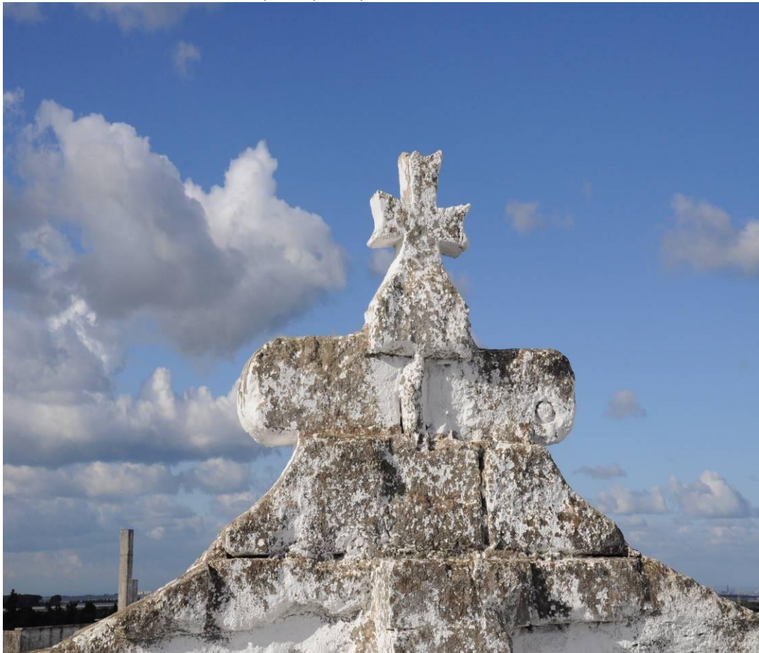
Particolare Frontespizio principale dell'Oratorio (dall' interno) (FTSP)
