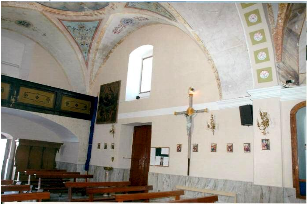
Un particolare dell'Aula (lato Ingresso secondario, dalla Piazza, oggi principale).
