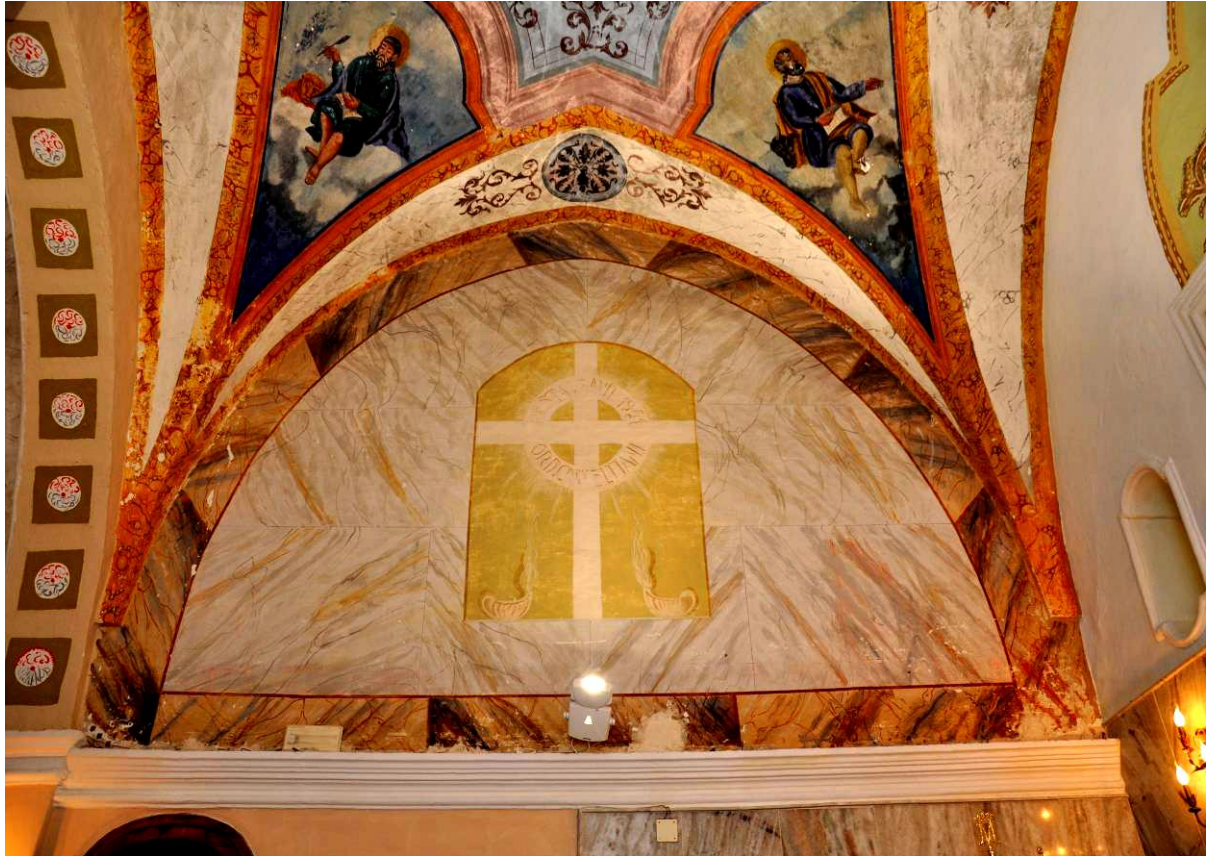
Lato Absidale sinistro (FTSP)
